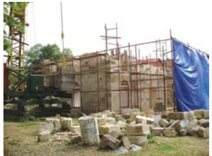
Obnova Ferhadije je u toku
