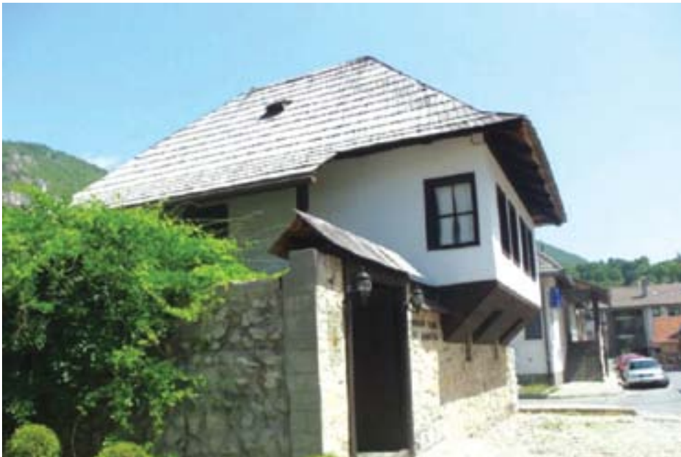
Rodna kuća nobelovca danas je muzej-restoran.
