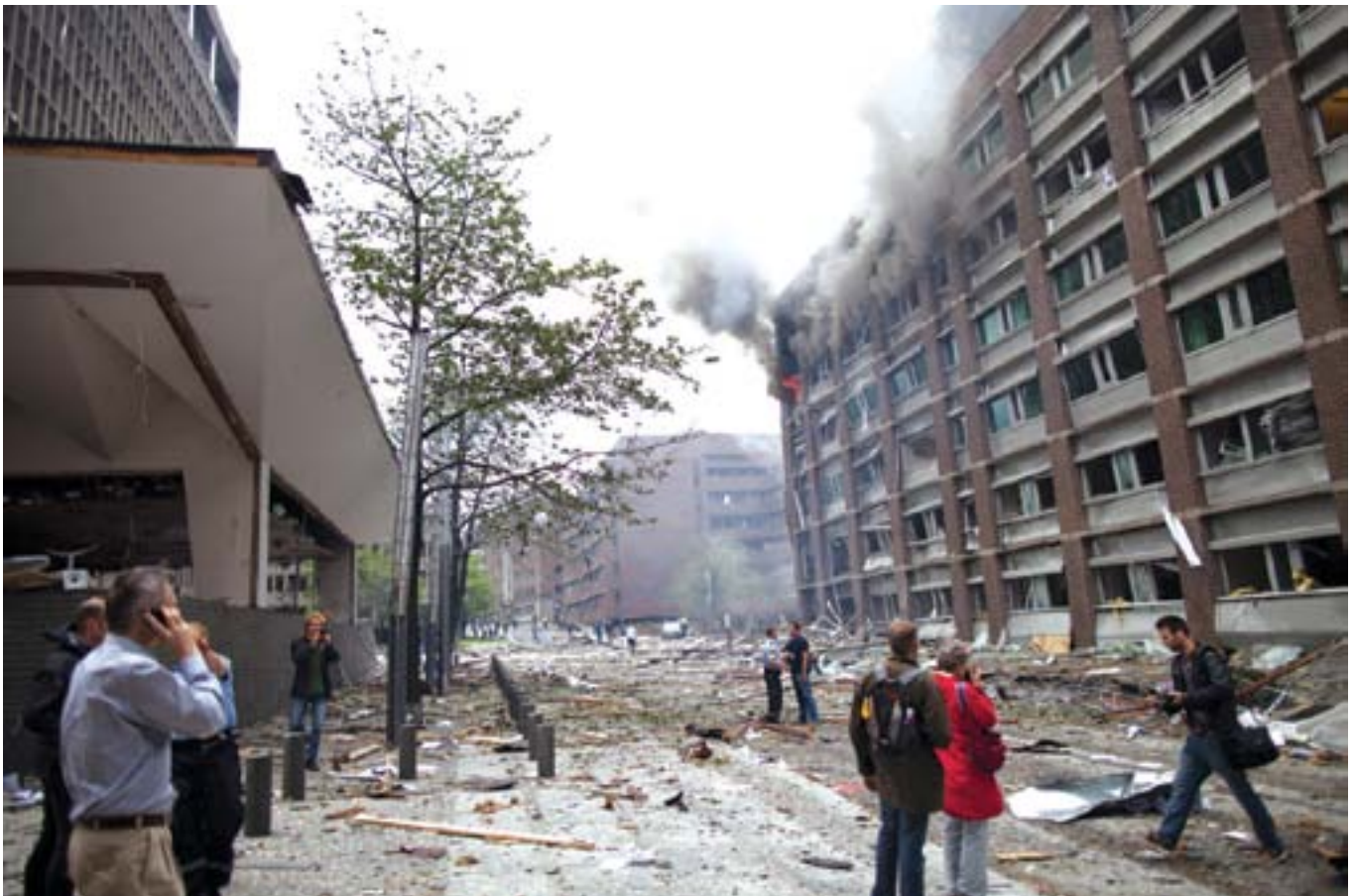
Eksplodija je uništila prozore na sedamnaestokatnici. Prizemlje i niži spratovi su teško oštećeni, ali je šteta vidljiva i na višim katovima
